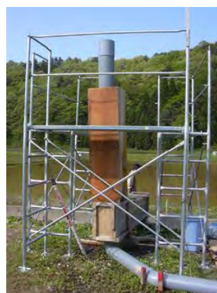
河川浄化装置
