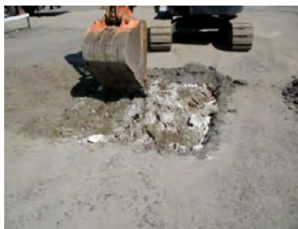
路盤改良実験の様子
