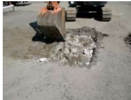
路盤改良実験の様子
